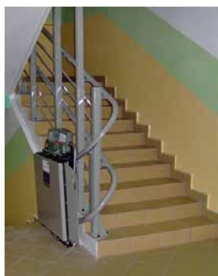
Fissaggio nell'occhio della scala
