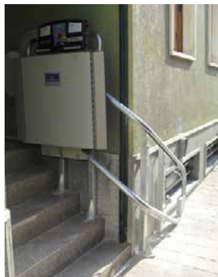
Fissaggio a gradino
