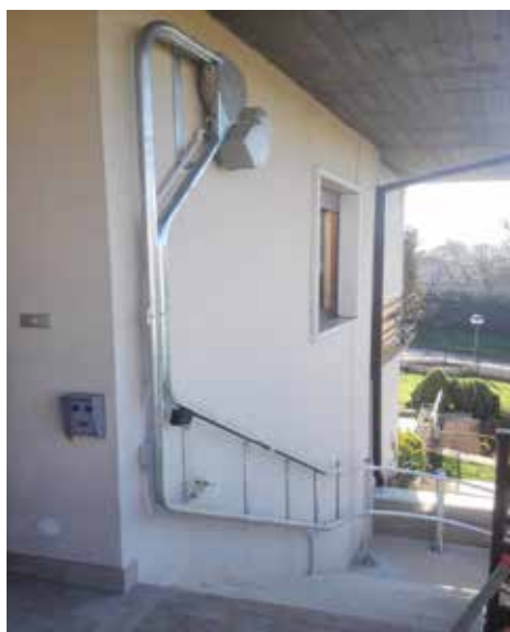
Motore "a collo d'oca" a soffitto
