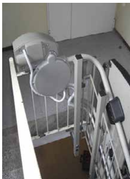
Motore a 90° nell'occhio della scala
