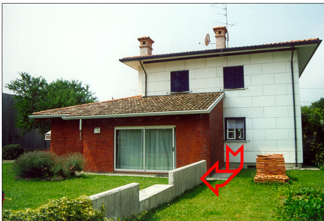
Foto n° 6 - Ingresso secondario e via di fuga.
