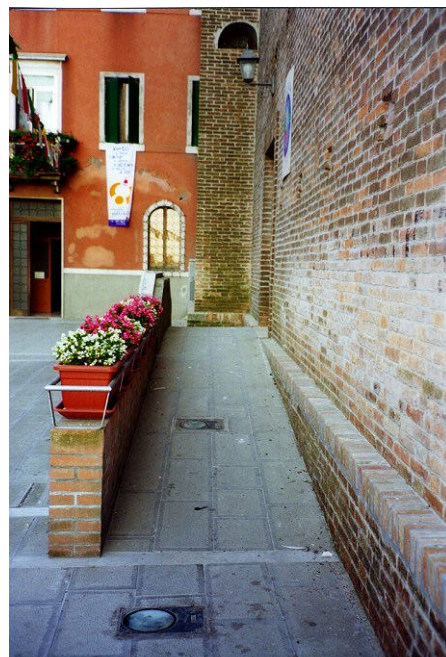
Figura 2: Altra veduta della rampa di accesso alla chiesa che frequenta Silvio
