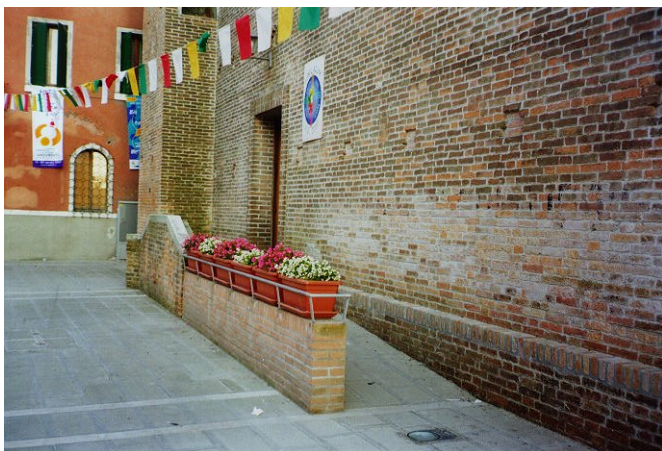
Figura 1: Rampa di accesso alla chiesa che frequenta Silvio
