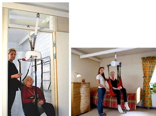
Il **sollevatore a binario** permette i trasferimenti lungo i binari montati al soffitto, c'è la possibilità per alcuni modelli di spostarsi anche da una stanza all'altra e superare delle porte senza che il paziente venga sganciato dall'imbragatura.
