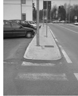
OSTACOLO DOVUTO A PALI DI SOSTEGNO ILLUMINAZIONE PUBBLICA
