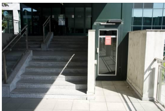
Fig.12.4 Rampa di scale di accesso e piattaforma elevatrice
