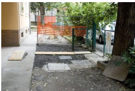
Fig.10.4 Lavori di risanamento degli spazi comuni del condominio
